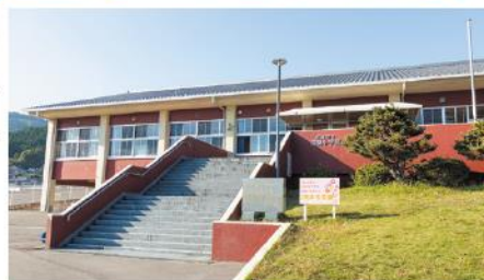
LX-10000F×1台、PX-M7050FX×1台を 導入されている武雄市立武雄小学校
